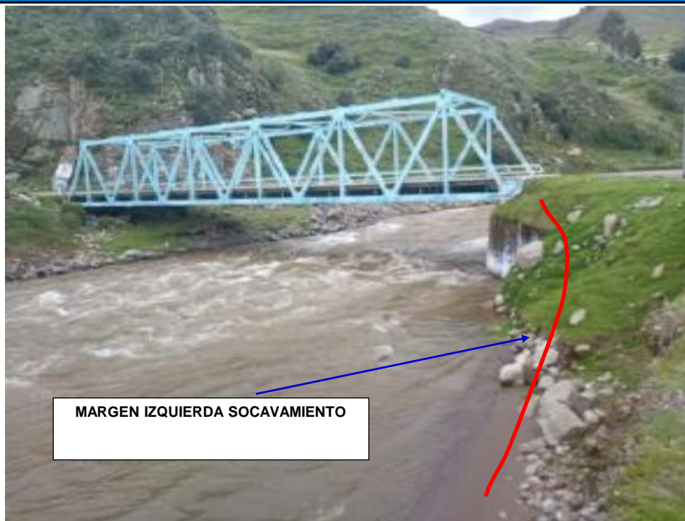
FIGURA N° 01: TRAMO CRÍTICO EN RIO VELILLE, CON SOCAVAMIENTO EN LA MARGEN IZQUIERDA
