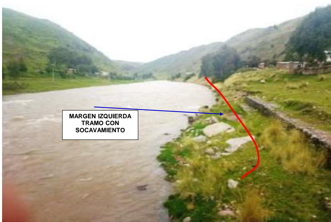
FIGURA N°03: EN LA TEMPORADA DE MAXIMAS AVENIDAS, RIO VELILLE CON TENDENCIA A DESBORDE EN LA PARTE PLANA DEL TRAMO.
